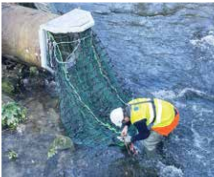
Le filet de rétention posé à Laigneville
