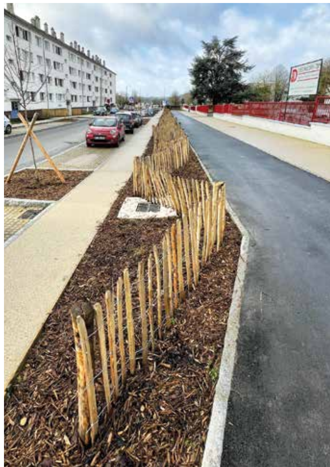
Aménagement des massifs drainants, rue du Général de Gaulle à Liancourt
